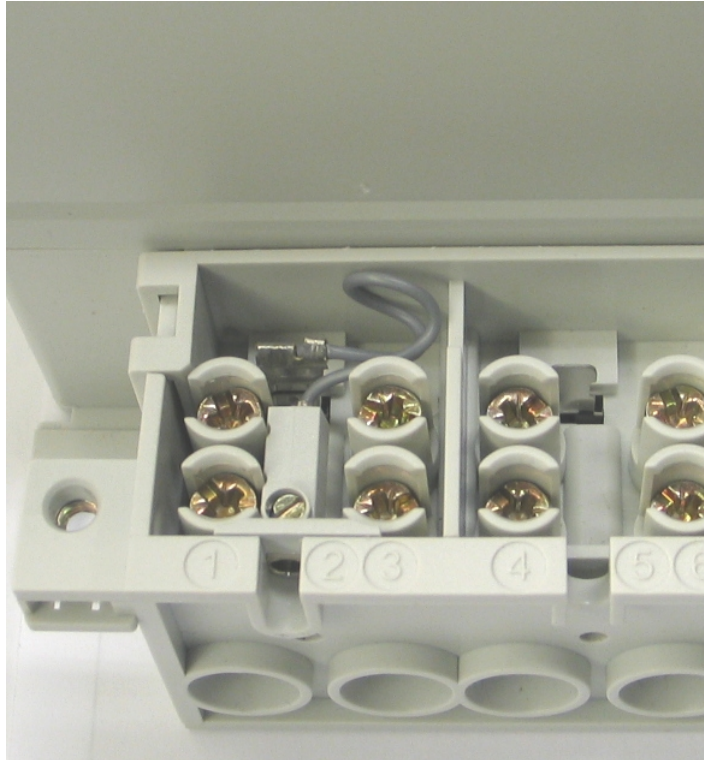
Figur 2. Installeret spændingsudgangsstik
